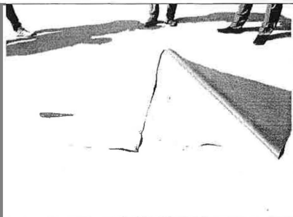
Рисунок 13. Вскрытие конструкции кровли на участке № 2 в пределах осей J-K/10-11.
