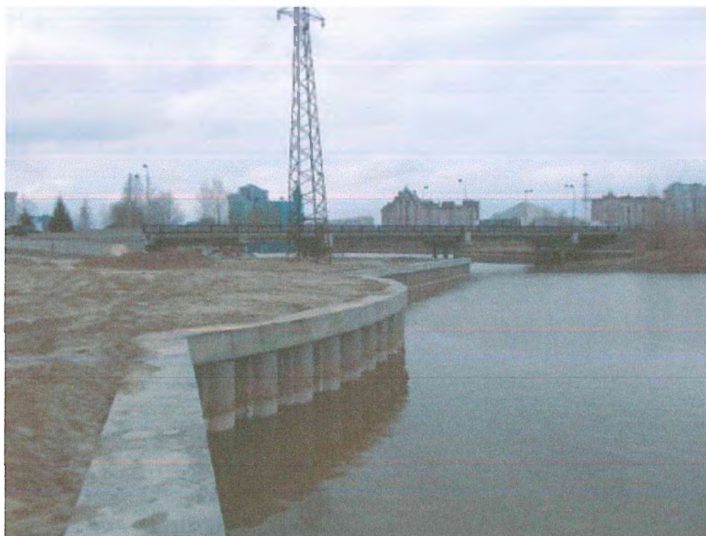
Фото В. 1 – Общий вид моста
