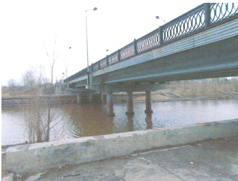
Фото В.2– Общий вид моста
