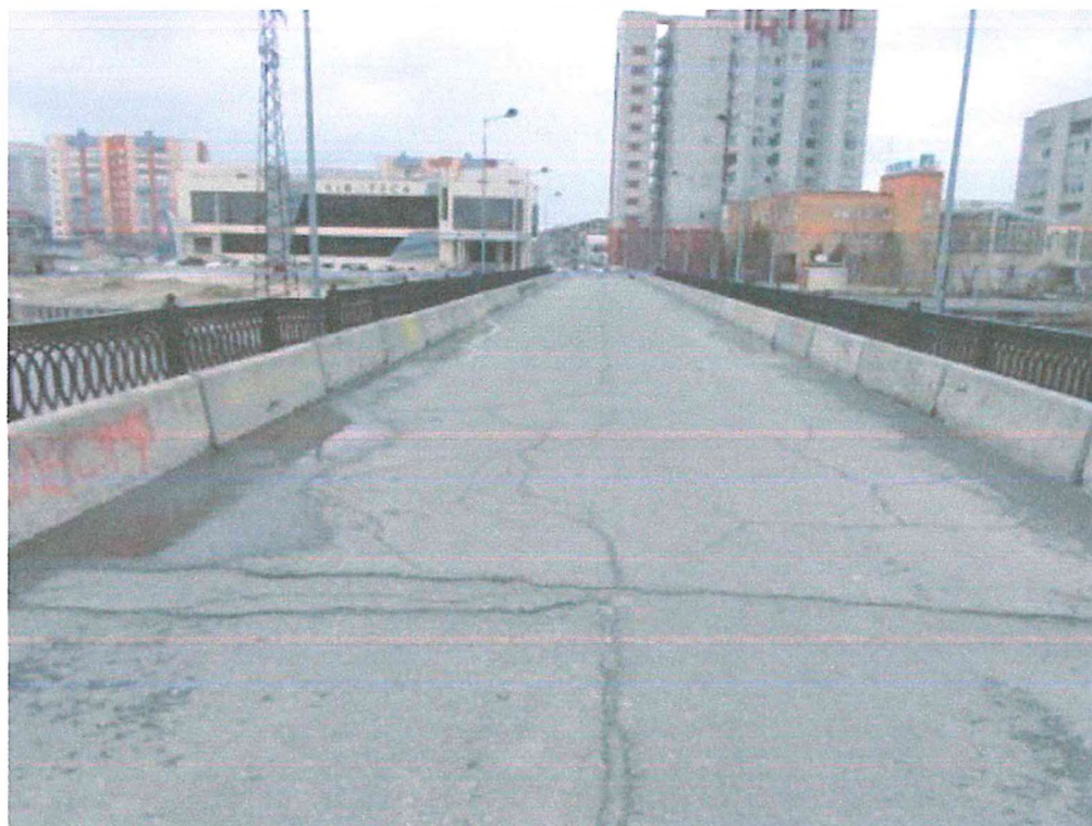
Фото В.4– Общий вид со стороны Университета
