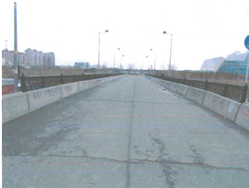
Фото В.3– Общий вид со стороны ул. Энергетиков
