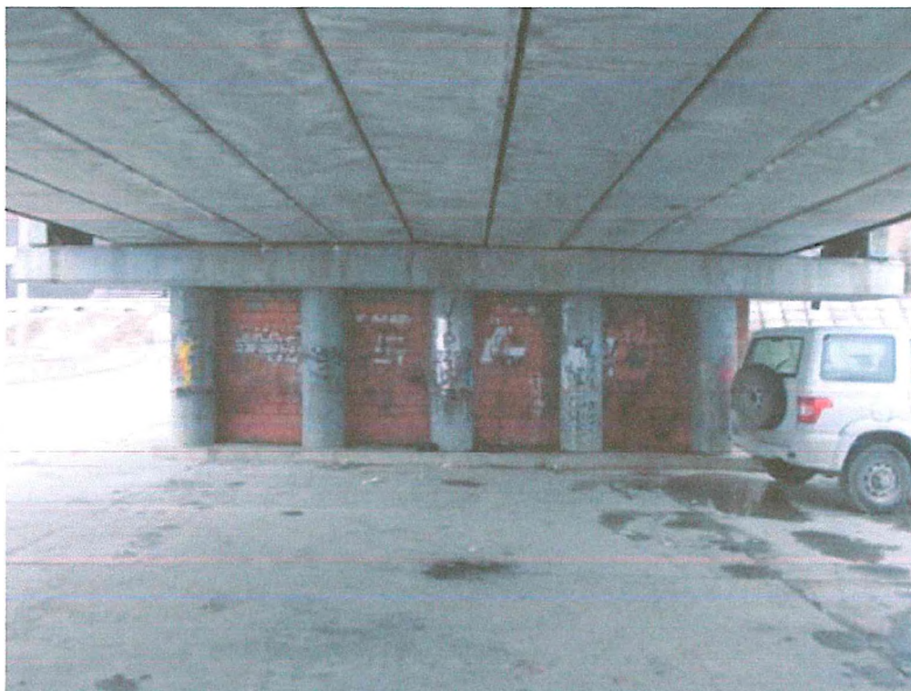
Фото В.5– Опорный узел устоя
