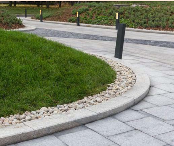
ГАЗОНЫ на границе используется бордюрный камень и возможно использование декоративного щебня
