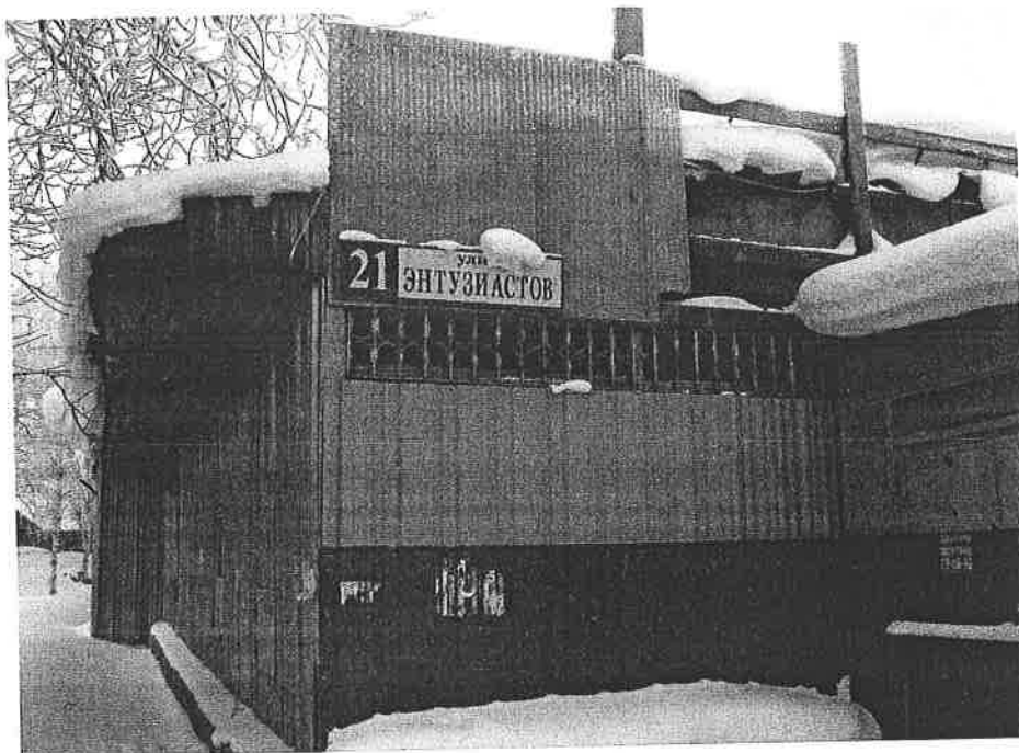
Фото 1. НЕЖИЛОЕ ЗДАНИЕ, , ОБЩЕЙ ПЛОЩАДЬЮ 168 КВ.М.
