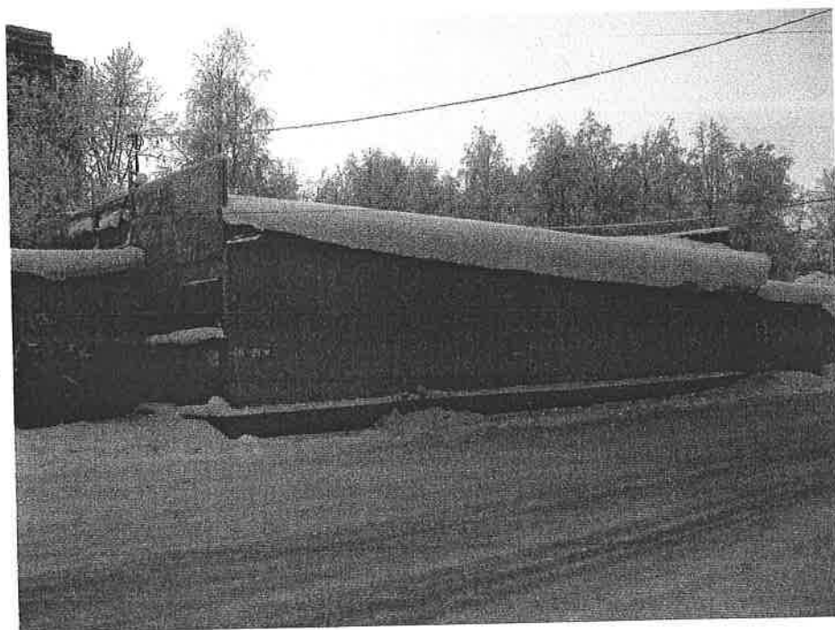
Фото 2. НЕЖИЛОЕ ЗДАНИЕ, , ОБЩЕЙ ПЛОЩАДЬЮ 168 КВ.М.
