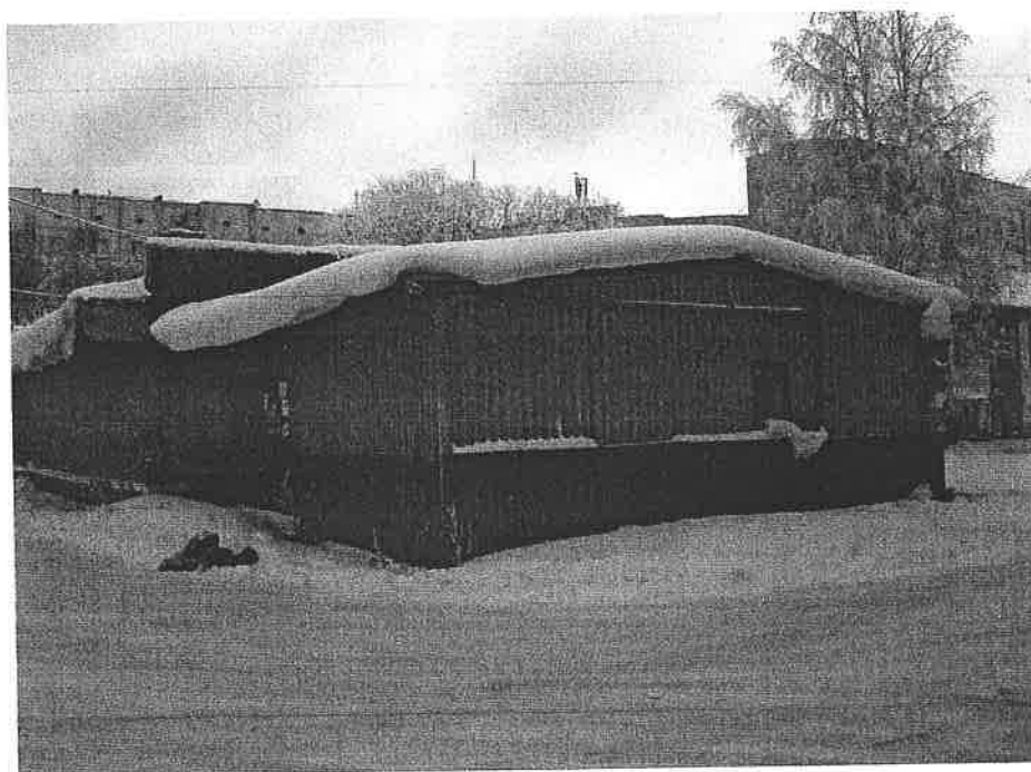
Фото 4. НЕЖИЛОЕ ЗДАНИЕ, , ОБЩЕЙ ПЛОЩАДЬЮ 168 КВ.М.
