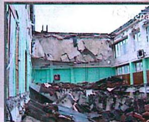
• В 2014Г. ПРИ ПРОВЕДЕНИИ РЕМОНТНЫХ РАБОТ ПРОИЗОШЛО ОБРУШЕНИЕ КРОВЛИ ЗДАНИЯ НА ПЛОЩАДИ 320КВ.М. ЧАСТЬ КОНСТРУКЦИЙ КЛУБНО-СПОРТИВНОГО БЛОКА НА МОМЕНТ ОБСЛЕДОВАНИЯ И ПРОЕКТИРОВАНИЯ БЫЛА ДЕМОНТИРОВАНА. В КЛУБНО-СПОРТИВНОМ БЛОКЕ ФУНКЦИОНИРОВАЛИ ТОЛЬКО ПОМЕЩЕНИЯ ПИЩЕБЛОКА
