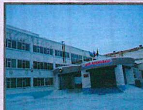
• НАРУЖНАЯ ОТДЕЛКА КЛУБНО-СПОРТИВНОГО БЛОКА ТРЕБУЕТ РЕМОНТА, ПРОИСХОДИТ ТЕПЛОПOTЕРЯ ЧЕРЕЗ ТРЕЩИНЫ В СТЕНОВЫХ ПАНЕЛЯХ, ЧЕРЕЗ МОНТАЖНЫЕ ЗАЗОРЫ. А ТАКЖЕ ОТСУТСТВУЕТ ОТДЕЛОЧНЫЙ СЛОЙ
